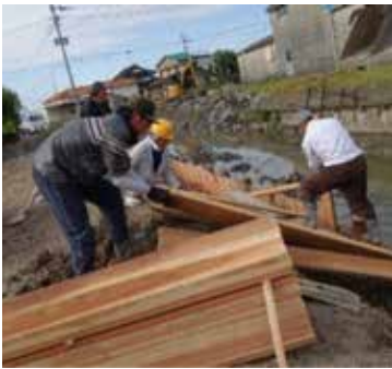
▲自分たちの手で水路工事
