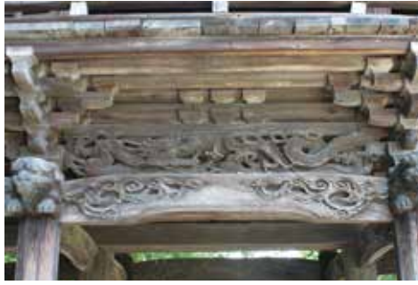
▲大藪田中の三島神社楼門
