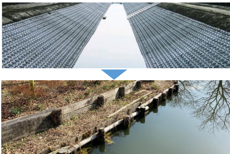
図 10 コンクリート製護岸（上）と木製護岸（下）
