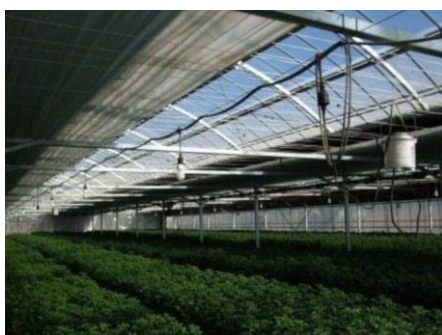
図 14 内張カーテン（左）と側面の空気膜2重被覆（右）
