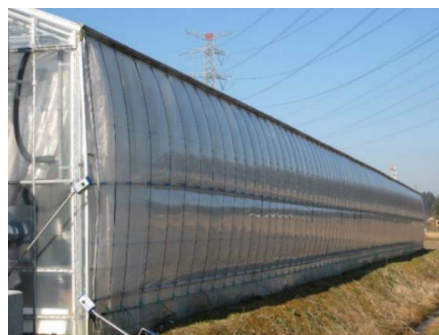
図 14 内張カーテン（左）と側面の空気膜2重被覆（右）
