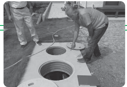
浄化槽点検の様子
