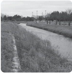
花宗川左岸堤防
