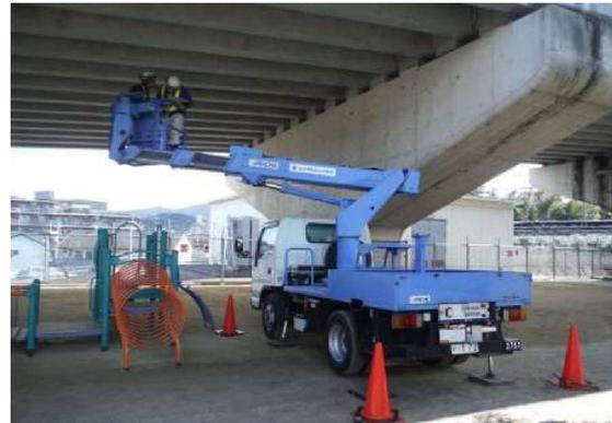
従来の点検方法（左：橋梁点検車、右：高所作業車）
