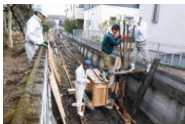
▲重機の入らない水路の護岸を人力で行う前牟田東（2015年）
