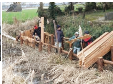
▲奥牟田西の木柵護岸工事（2015年）
