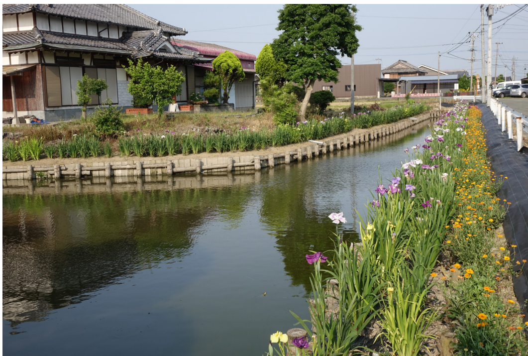
堀田区で施工された木柵。写真右側の木柵は2段づくりとなっており、大量に堆積していた浚渫土を活用して、水辺の花壇を整備している。（P20の写真参照）
