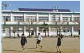
▲全小中学校に設置された太陽光発電パネル
