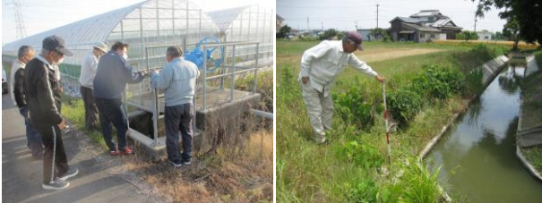
樋門の点検/中島
