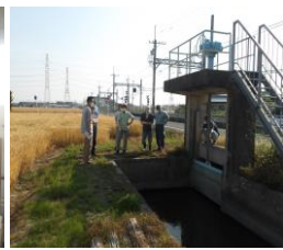
水門の機能診断/蛭池
