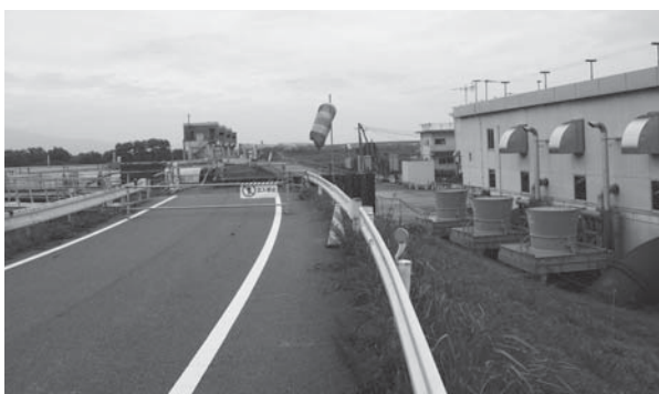
山ノ井川排水機場と樋管の更新工事の状況
