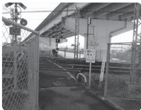
高架下の踏切
