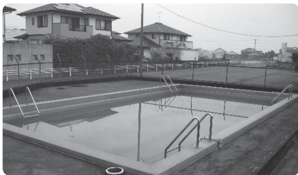
浄化設備のないプール
