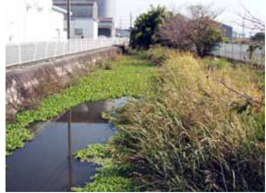
上八院地区の水路整備予定地 (農村環境整備事業)
