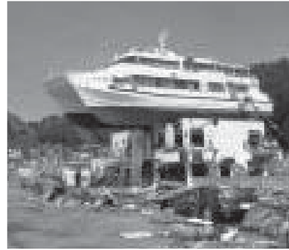
東日本大震災の被災状況
