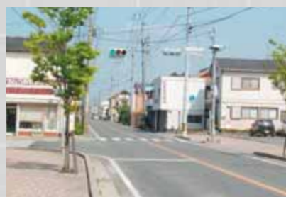
現 442号歩道未整備
