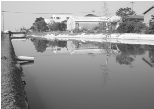
環境に配慮した工法で整備された水路
