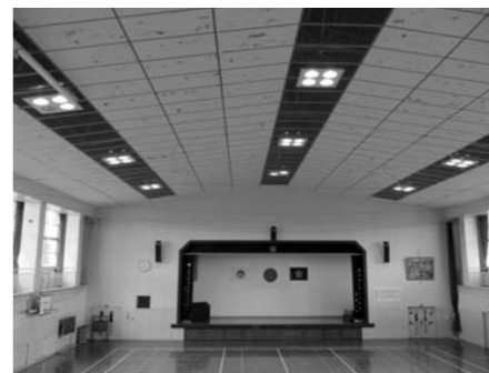
下から見た吊り天井
