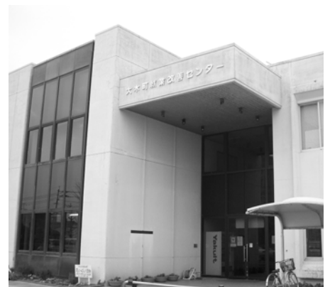
就業改善センターのアスベスト除去や雨漏り対策を行います
