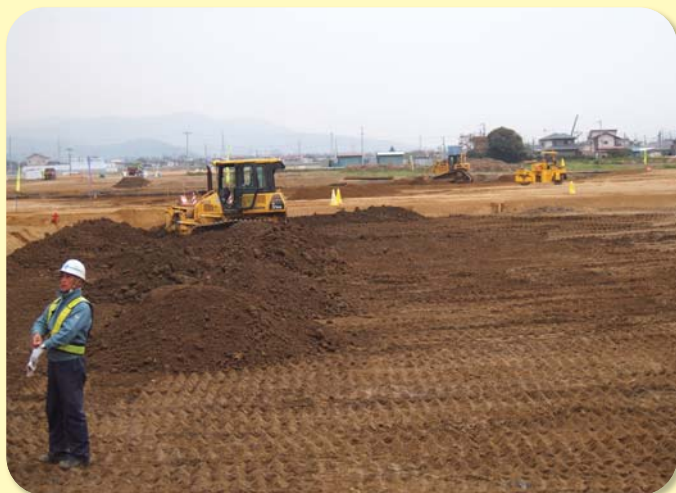
被災者向け住宅造成工事
