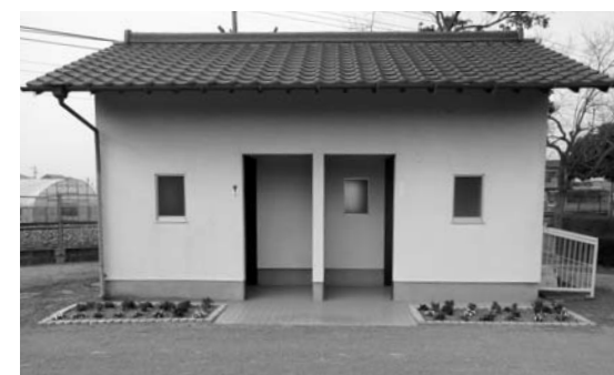
石丸山公園北側駐車場トイレ
