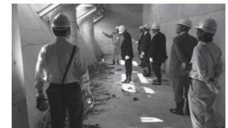
地下調整池の流入口のようす
