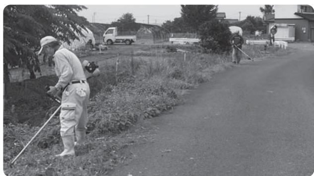
刈り払い機による法面の除草
