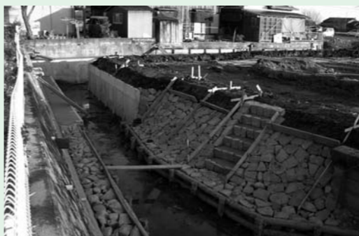
掘割再生の工事状況
