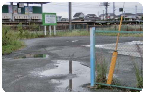
未整備の大溝駅前広場
