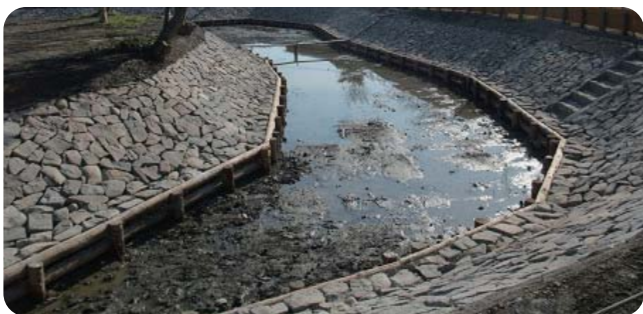
生物多様性に配慮した護岸工事
