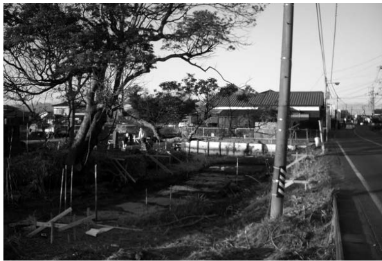
掘再生の工事状況
