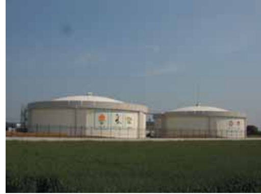
久留米市共同配水場
