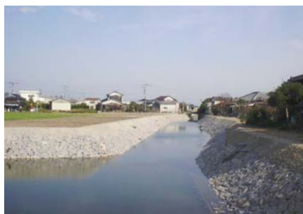
多自然型護岸工事
