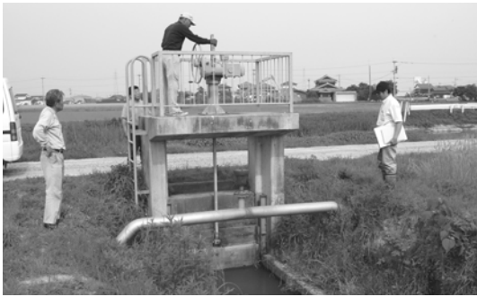
前牟田東地区で行われた施設点検の様子
