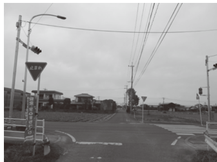
信号機が設置される通学路交差点
