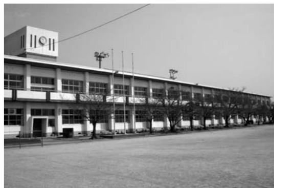
増改築工事が計画されている大溝小学校
