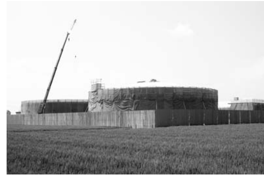
建設中の久留米市西部（旧三潞郡）配水場
