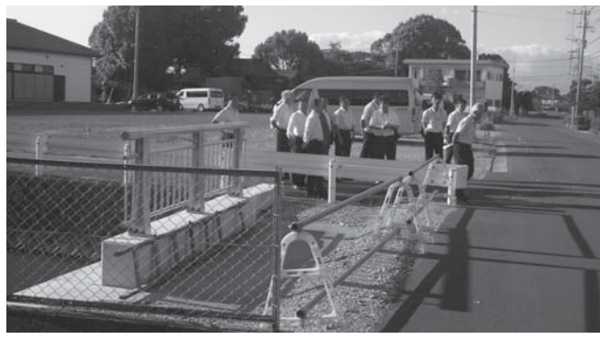
三八松の橋梁整備事業の 完成状況確認
