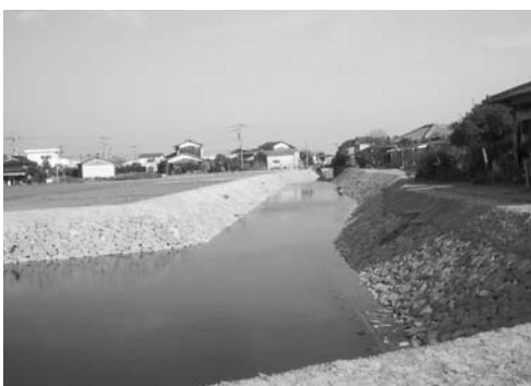
多自然型護岸工事
