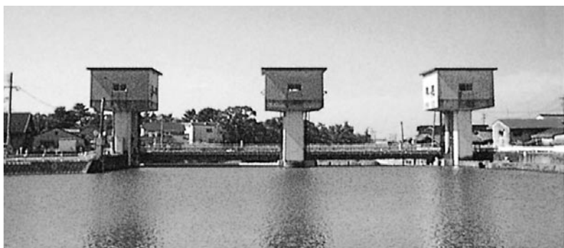
仮稼働している新酒見堰
