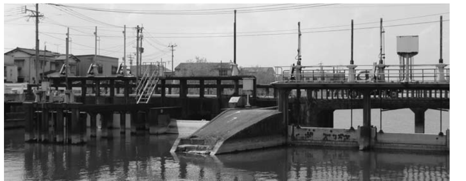
撤去予定の旧酒見堰(橋りょうと一体となっているため橋りょう架替の完成後となる)
