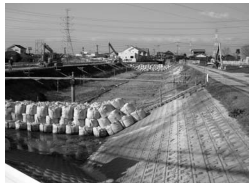
国営幹線水路農地防災事業
