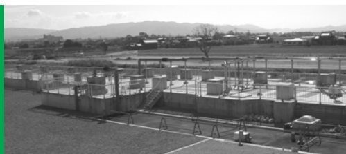
建設中の矢部川浄化センター
