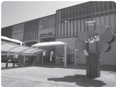
筑後船小屋駅
