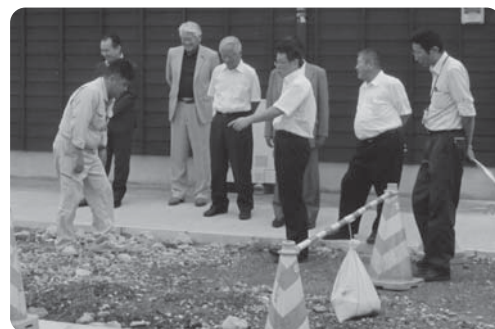
町道八町牟田10号線拡幅工事現場視察
