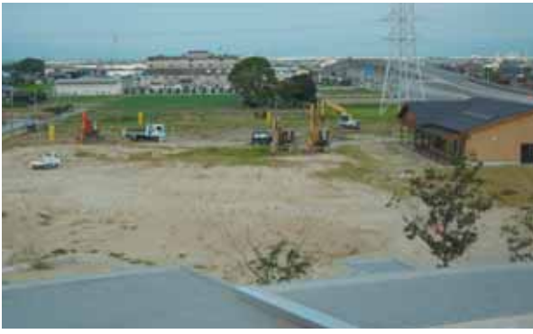
液肥タンクから見た 2 期工事
