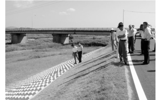
復旧された堤防
