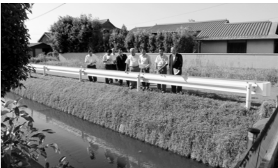
クレーク防災事業機能保全対策事業視察状況
