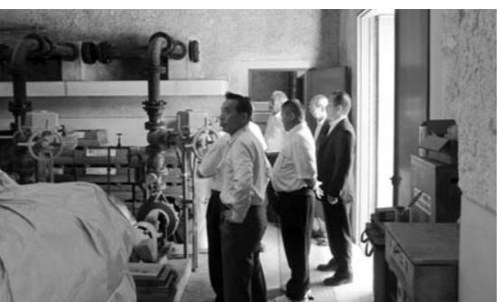
旧配水場の視察状況
