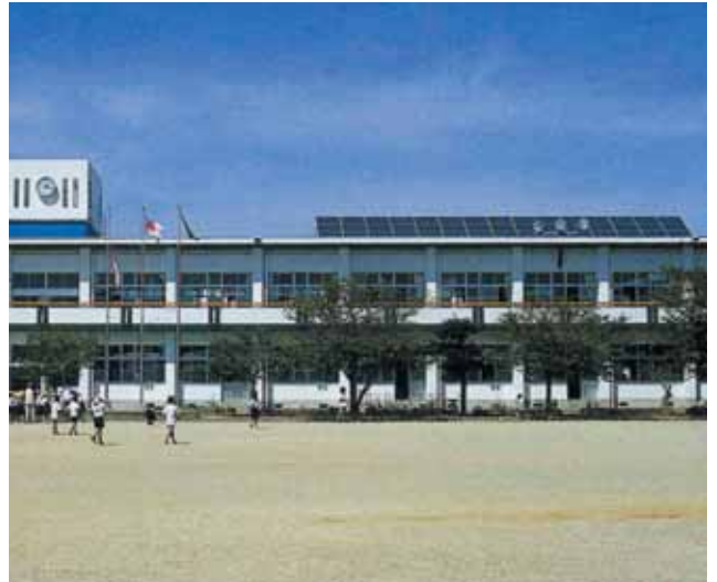
大溝小学校校舎屋上の太陽光システム
