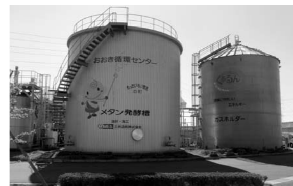
くるるんメタン発酵槽
