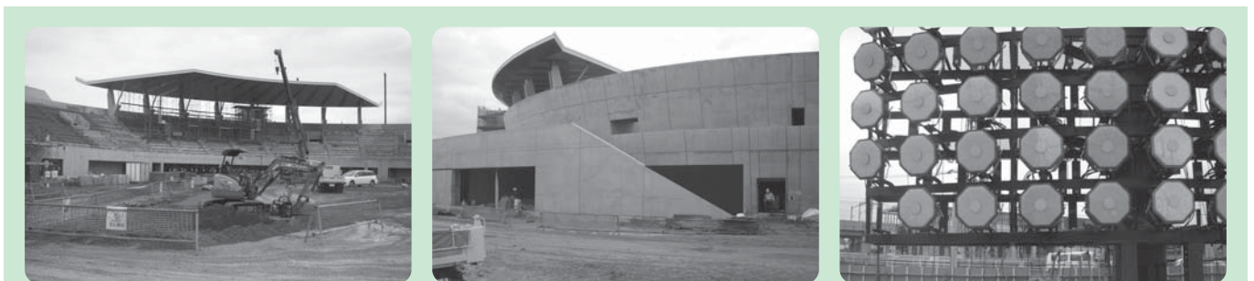
ホークスペースポールパーク筑後の建設風景
