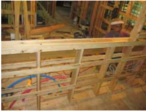
住宅リフォーム工事
