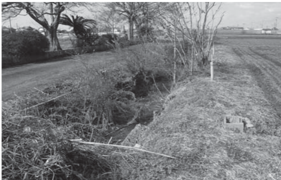
工事前の様子
