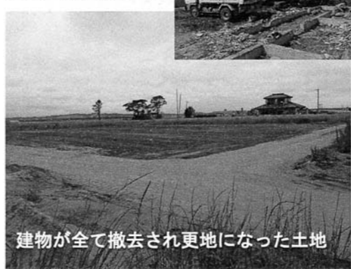
瓦礫処理・被災家屋の解体(分別解体・分別収集)
