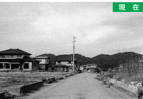
東名地区 多くの住宅が撤去された
