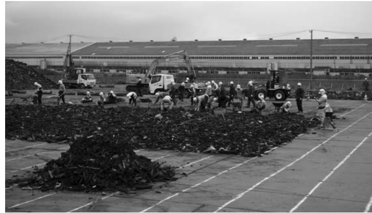
被災者の雇用の場ともなっている被災ごみの分別作業
