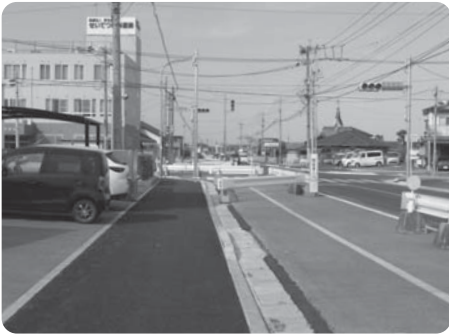
久留米柳川線自歩道工事
