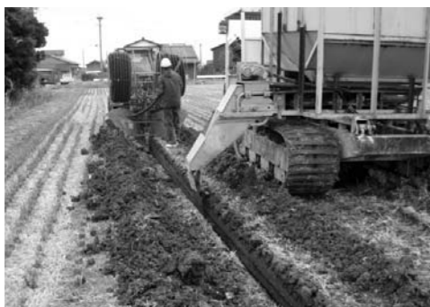
平成25年度大木町での工事のようす
