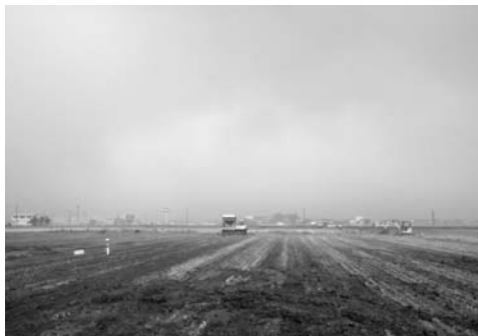
城島の暗渠布設状況
