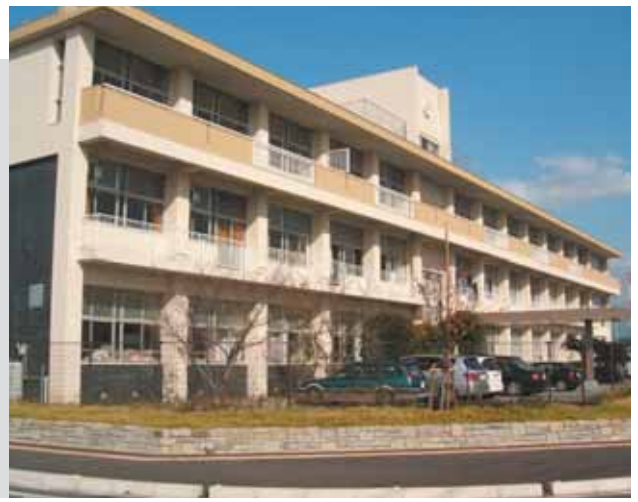
平成19・20年度において大木中学校大規模改修を行った
