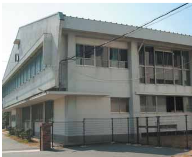
大木中体育館耐震補強工事予定
